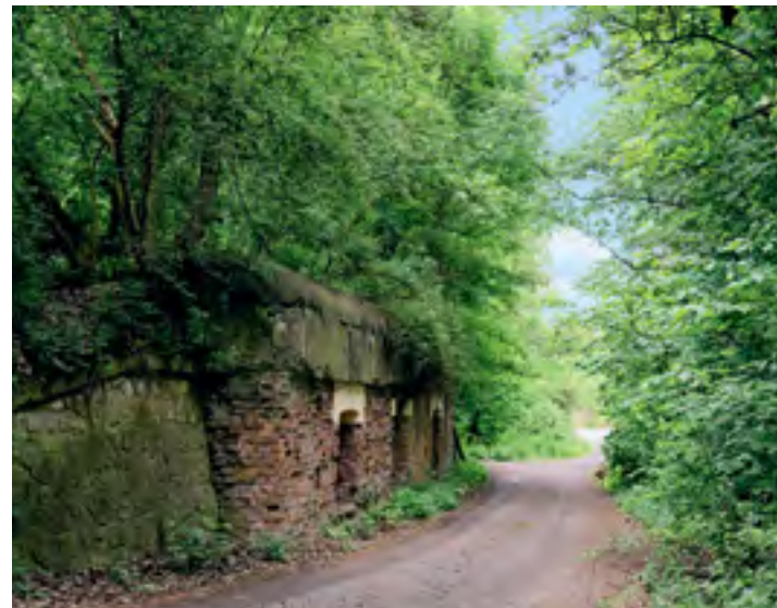
Schron amunicyjny przy ul. Tetmajera
