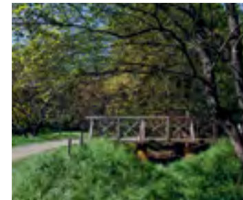
Mostek na Młynówce Królewskiej w rejonie ul. Zygmunta Starego
